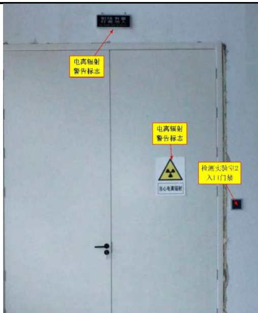
检测实验室 2 入口门禁系统、电离辐射警告标志和工作状态警示灯
